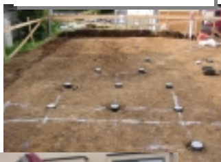
パイプの余った部分を切り取り、地盤補強が完了した所
