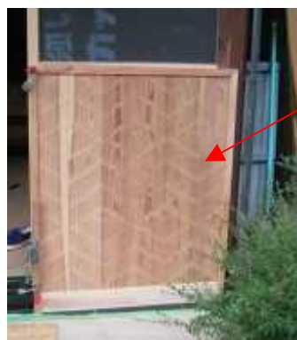
杉板の矢羽根なぐり加工
