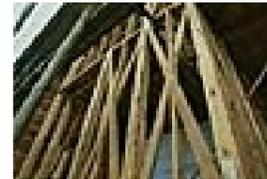
①軸組工法(在来工法) 柱・梁構造なので、増改築が容易。通気性が良い。
