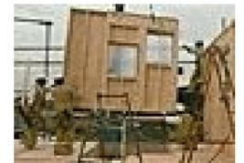
②枠組壁工法(ツーバイフォー工法) 壁と柱の隙間がないので断熱性が高い。
