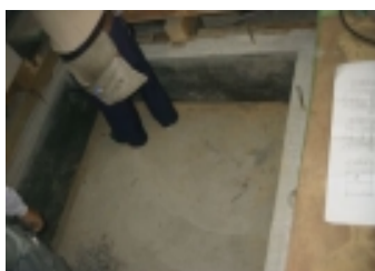
▲土台もすっきり固まりました。エレベーターの1階ピットが出来上がり
