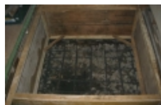
▲土台には、砕石を入れ、その上に鉄筋を組みます。この型枠の組み方は難しい職人技。コンクリートを一度に流し込めるから作業がよりスムーズに進みます。
