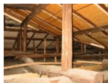
屋根の内部。曲がりかねた梁にビックリ!
