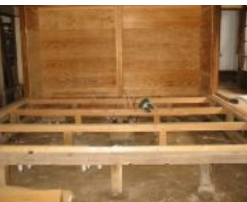
耐震補強もしっかり行い、内装の床部分の基礎が出来上がっています。
