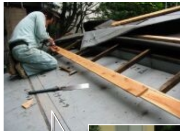
屋根の上での作業が続きます。
