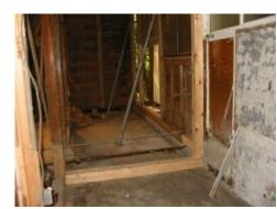
▲土台を取り替え、柱を補強をした所。
