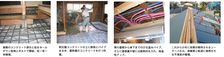
基礎のコンクリート部分と柱をホールダウン金物とボルトで繋結。柱一本一本補強。 耐圧盤コンクリートの上に鉄筋とパイプをおき、蓄熱層のコンクリートを打つ作業。 家の屋根から床下までのびる温水パイプ。さらに屋根裏や壁には断熱材を入れ、保温性アップ。 これからの冬に効果が期待されるソーラーパネル。床暖房と給湯に使用される不凍液が循環。
