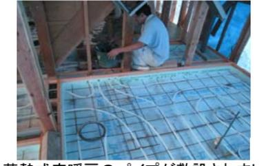
蓄熱式床暖房のパイプが敷設されました。蓄熱コンクリートから出る輻射熱はひなたぼっこの気持ちよさです。
